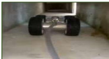
Una vez realizada la inspección inicial, se procede a la limpieza. Dentro de las distintas alternativas de limpieza se aconseja seguir, uno de los tres métodos ampliamente recogidos en la norma UNE 100012:2005: por aspiración de contacto, con aire a presión y/o con cepillado mecánico.
